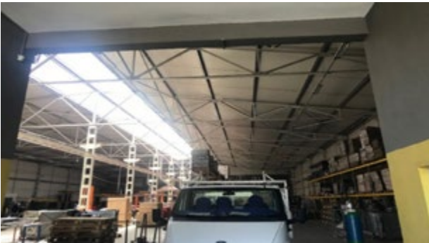
Şek. 4. Organize Sanayi Bölgesi yapılarından birine ait çatı ışıklığı örneği
