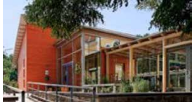
Şekil 18- 21. Kil bloklarla çevrili ahşap karkas yapı duvarları (URL_13)
