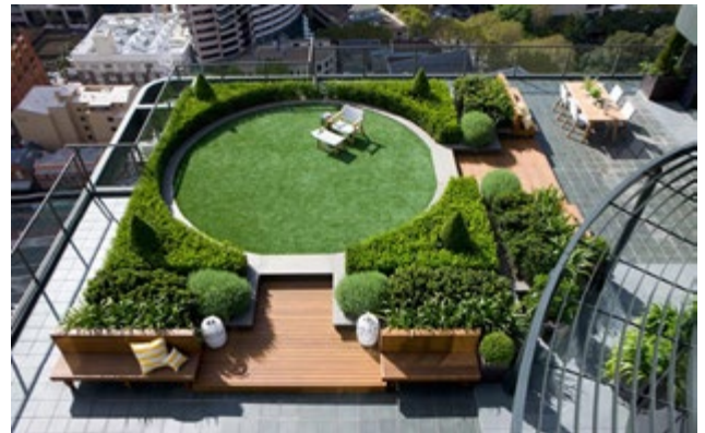
Şekil 1. Çatı Bahçesi Örneği
